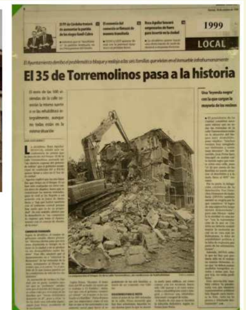
DEMOLICIÓN BLOQUE 35 C/ TORREMOLINOS
