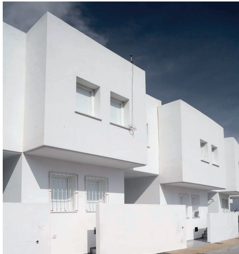
Actuación en Cuevas de las Palomas Actuación en Cerrillo del Hambre pertencientes al Programa de Rehabilitación del Barrio de la Chanca (Almería)
